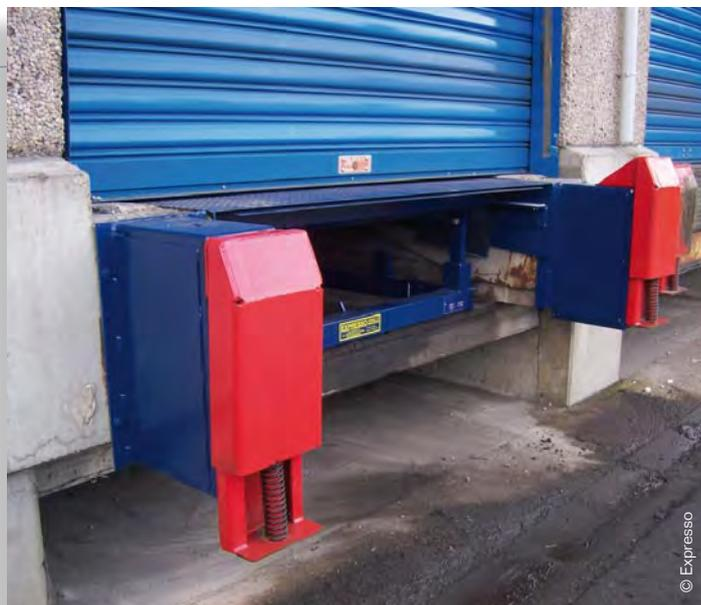
Lorsque l'entreprise reçoit des camions de hauteur multiple, l'un des butoirs pourra être implanté au dessus du plan du quai. Ce montage protège le matériel sans compliquer le transbordement des palettes disposées au plus près des portes du camion.
