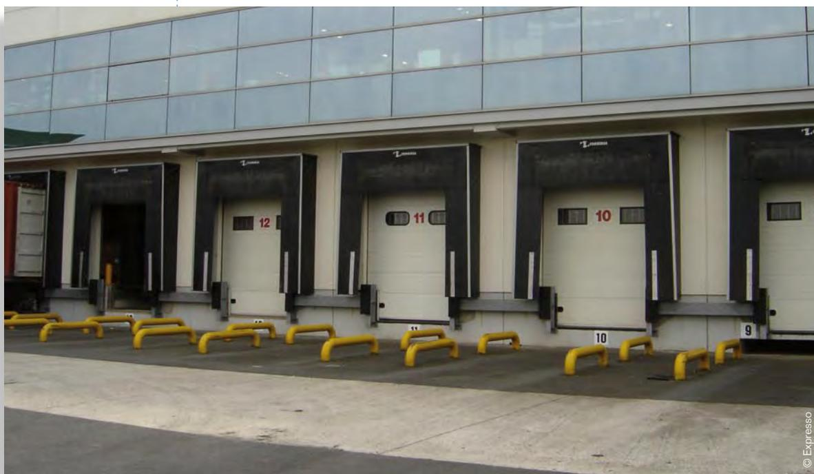
Guide-roues avec aire de béquillage
